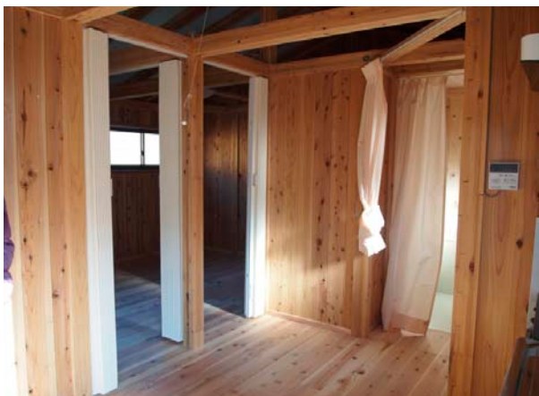
住田町仮設住宅内部 入口よりDKから2居室、浴室、便所の入り方を見る
