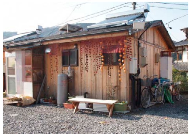
住田町住宅外観(北より) 「花、干し柿、ベンチ、自転車…、設備機器」
