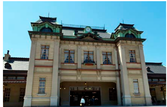
文化財保存修理事業が完了した門司港駅 写真：photoAC提供
