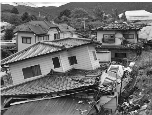
益城町県道28号沿い
