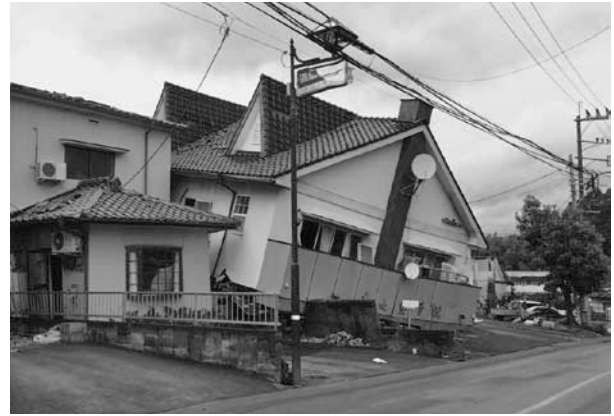
益城町県道28号沿い
