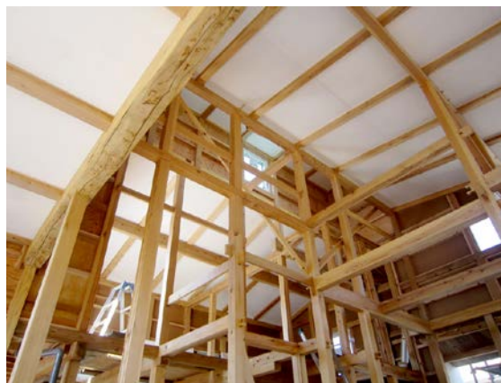
「櫓の家」上棟後、内部
